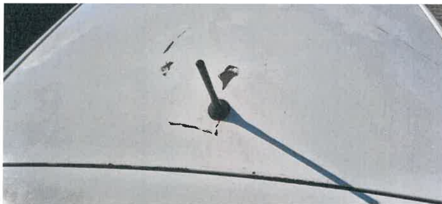
Porysowany dach w tylnej części
